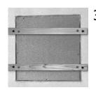
Mit zwei Dachlatten lässt sich der Rahmen einfach in Position bringen und fixieren. Mit Bauschaum die seitlichen Fugen aus schäumen und warten bis der Rahmen fest und stabil in der Nische sitzt.
