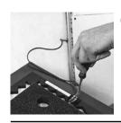
Die Anschlussleitung mit den beiliegenden Kabelschuhen fachgerecht verpressen. Danach das Kabel an den Anschlussklemmen anschließen, dabei auf die Polarität achten.
