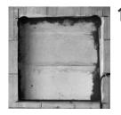
Für den Einbau der unsichtbaren Lautsprecher von cerasonar wird ein Einbaurahmen benötigt. Dieses Zubehörteil ist für jedes Modell verfügbar. Dazu muss eine entsprechende Nische im Mauerwerk geschaffen werden. Diese sollte umlaufend ca.2 cm größer sein. Zur Kontrolle den Mauerwerksrahmen in die Nische zu platzieren.
